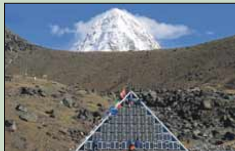
Una veduta notturna della piramide, il laboratorio più alto del mondo costruito dal Cnr in Nepal, e la squadra di operatori all'opera per sostituire i pannelli solari
